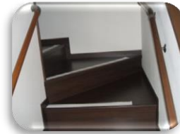
手すりに滑り止め！ 安全面もバッチリ♥
